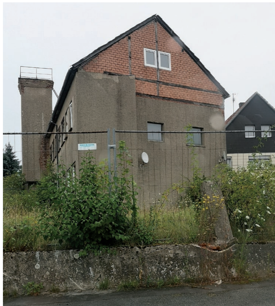
Die ehemalige Möbelfabrik Ackermeier in Niese. Das Gebäude verfällt und ist nur notdürftig mit Bauzäunen gesichert.
