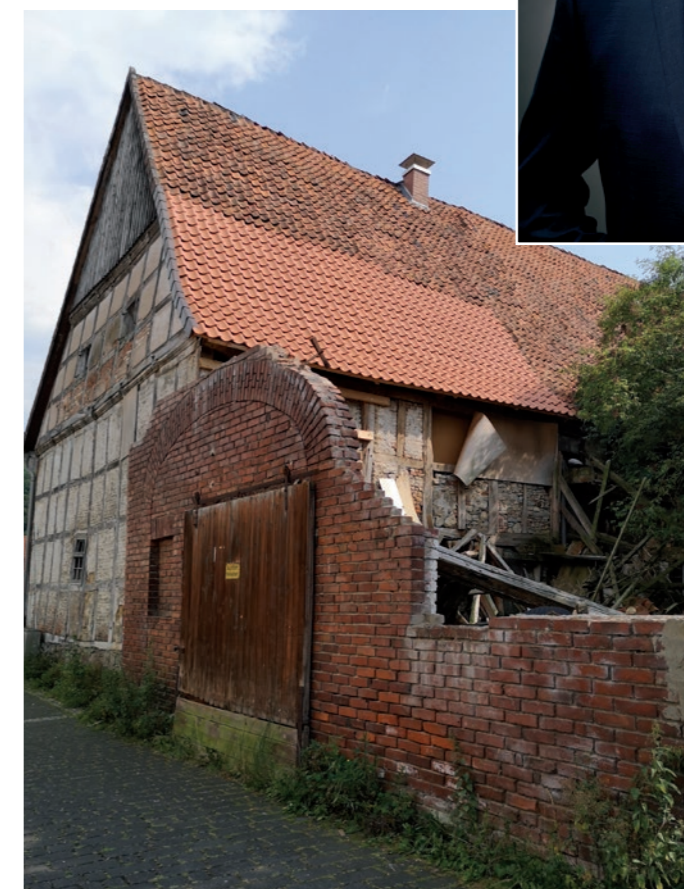
Das Fachwerkhaus Mittlere Straße 48 steht seit Jahren leer. Lange Zeit zum Handeln bleibt nicht.
